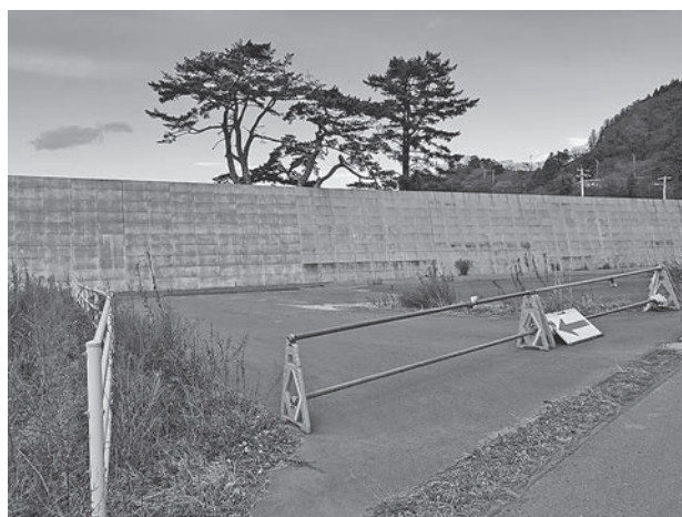
図 3-3 防潮堤と松の木 (2020 年 12 月 6 日)
